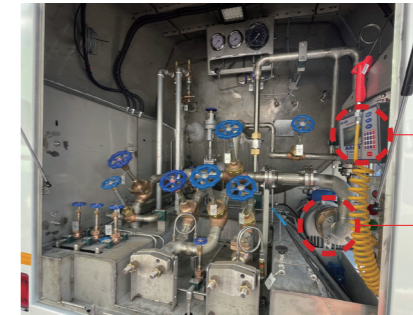
Inside of the Valve box (밸브박스 내부)
